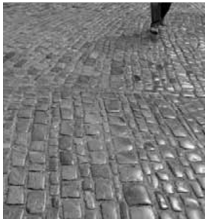
Obr. 25. Dlažba z opracovaných kamenů kladených do řádků.
