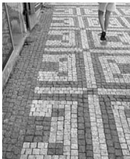
Obr. 61. Chybný výběr nebo rozvrh vzoru vzhledem k šířce chodníku.
