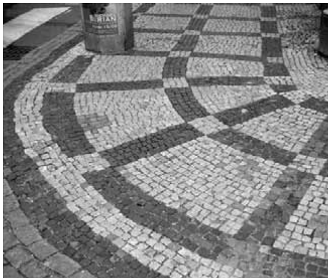
Obr. 2. Sedmdesátka (bez dámy). Správné provedení s ojedinělým bílým mramorem, použitým vzhledem k významu budovy. Vzor probíhá plynule kolem budovy a je zakřiven kolem nároží. Byl poškozen při předláždění.
