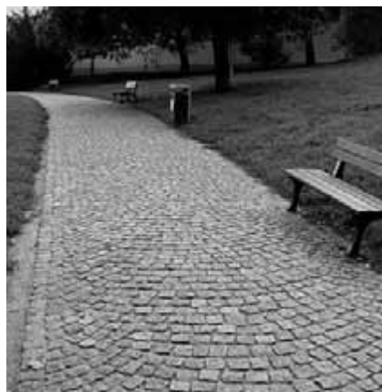
Obr. 53, 54. Dlažba z drobné kostky kladená do kroužků. Ohlazený líč původních kostek kontrastuje s hrubým povrchem nových (obr. 53).
