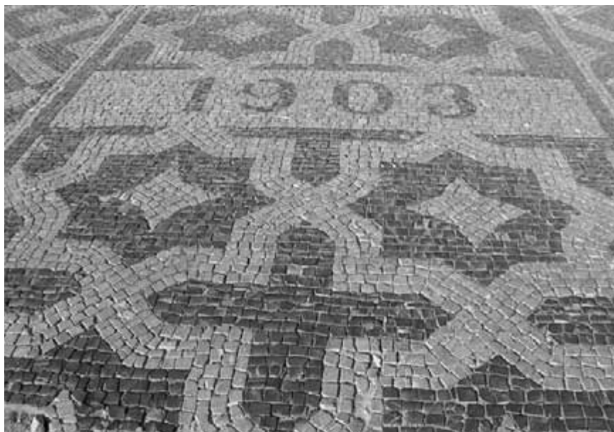
Obr. 13. Složitá kombinace správně provedených vzorů s datem 1903. Při opravě poškozené části dlažby (viz vlevo dole) bude nutné použít původní sekané kostky a vzor pečlivě doplnit.
