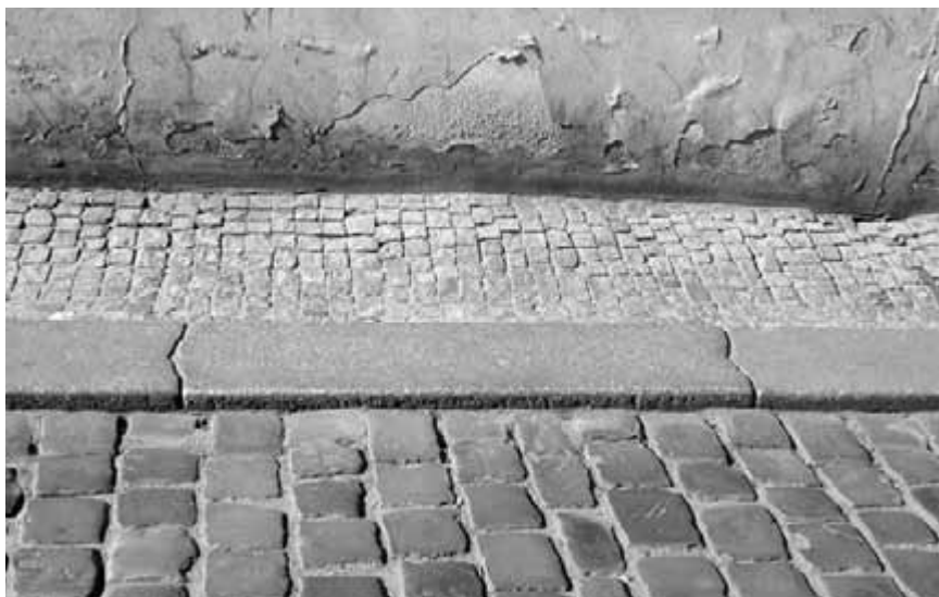
Obr. 30. Běžné masivní žulové obrubníky, kladené na sucho a se zámkem směřujícím doprava.
