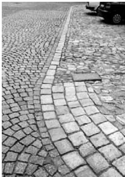
Obr. 44, 45. Srovnání drobné kostky s jinými dlažebními materiály.
