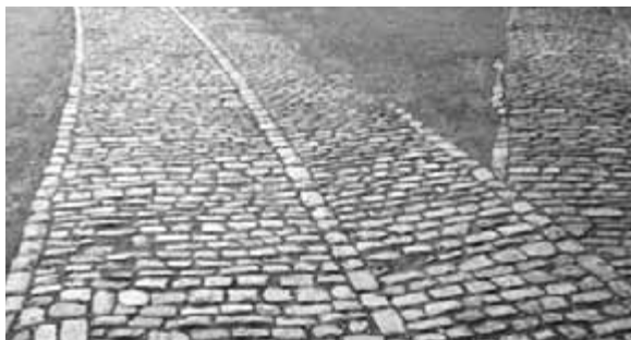
Obr. 20. Mlatová úprava s jízdními pruhy dlážděnými opracovaným kamenem kladným do řádků.
