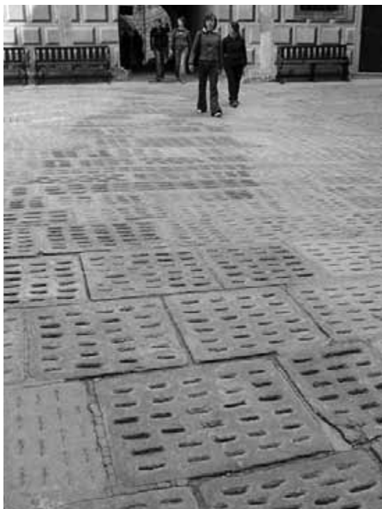
Obr. 33. Kamenné desky s vytesanými drážkami, které zřejmě měly zabránit uklouznutí.
