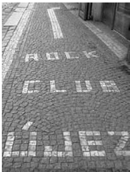
Obr. 14. Nevhodné novodobé uplatnění nápisu v chodníkové dlažbě, k němuž se navíc přidává nevhodné obloučkové dláždění plochy.
