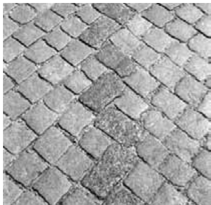
Obr. 50. Dlažba vozovky z drobných kostek I. třídy, sestavená ze zalomených řad, střední linie „vazáků“ je odlišena barevností horniny.
