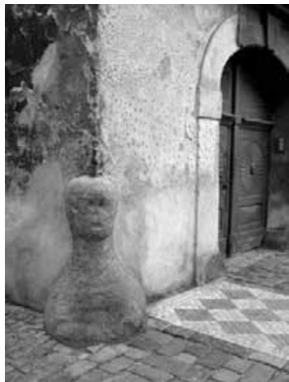
Obr. 97. Nárožní kámen unikátního tvaru, vpředu je patrná velká dlažba řádková.
