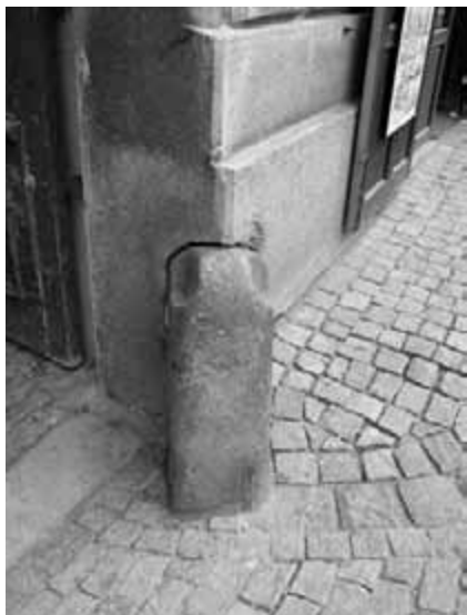
Obr. 96. Nárožní kámen chránící ostění vjezdu do dvora.
