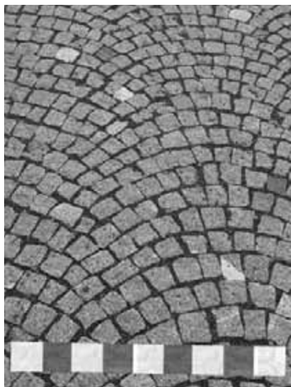
Obr. 67. Novodobá sekaná chodníková mozaika v kroužkové skladbě (pravděpodobně žula).
