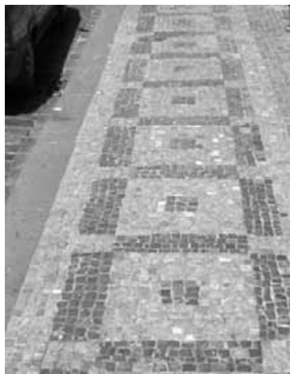
Obr. 4. Nesprávné provedení vzoru šedesátka s dámou. Středový čtverec je výrazně menší než ostatní části vzoru, ale má být větší. Případ je o to horší, že byla použita původní štípaná mozaika, z níž mohl být bez problému proveden kterýkoli z historických vzorů.
