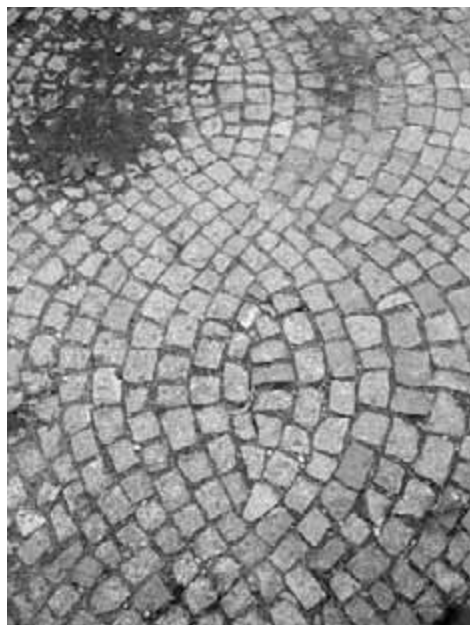
Obr. 36. Ani mladší, kvalitně provedené dlažby by neměly být zbytečně likvidovány a nahrazovány jinou, dokumentací nedoloženou povrchovou úpravou (ať již historizující, nebo zcela novodobou).
