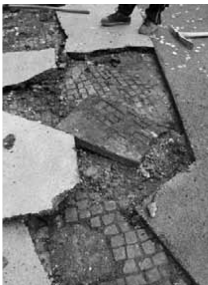
Obr. 110. Bourání asfaltového koberce přelitého přes chodníkovou mozaiku. Tento koberec lze často jednoduše odstranit.
