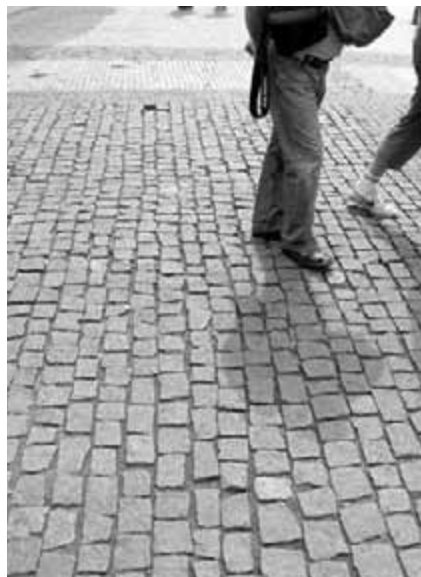
Obr. 47. Dlažba z drobných kostek, schéma skladby z kostky I. třídy.
