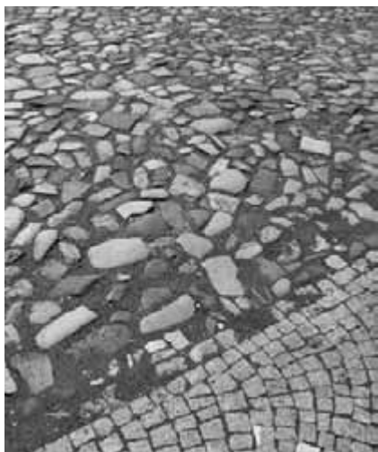
Obr. 13. Srovnání nepravidelného kamene a novodobé sekané žulové chodníkové mozaiky.
