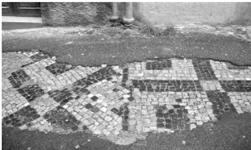
Obr. 40. V městských ulicích byly někde před jednotlivými domy použity odlišné vzory chodníkové mozaiky. Pečlivá dokumentace podobných pozůstatků původního provedení a jejich respektování při předlažbě by měly být samozřejmostí.
