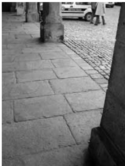
Obr. 35. Dlažba podloubí z novodobých žulových desek.
