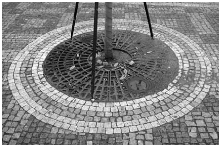
Obr. 29. Nesprávné lemování plochy u paty stromu. Vložené prvky, včetně rabátek, se bordurou v chodníkové mozaice nezvýrazňovaly. Hodnotným prvkem je krycí mříž.
