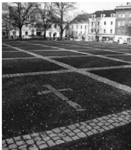
Obr. 106. Plocha náměstí je dělena třemi řádky drobné kostky na jednotlivá pole, vyplněná asfaltem se zavalcovaným štěrskem. Kříž z velkých kamenů značí památné místo.
