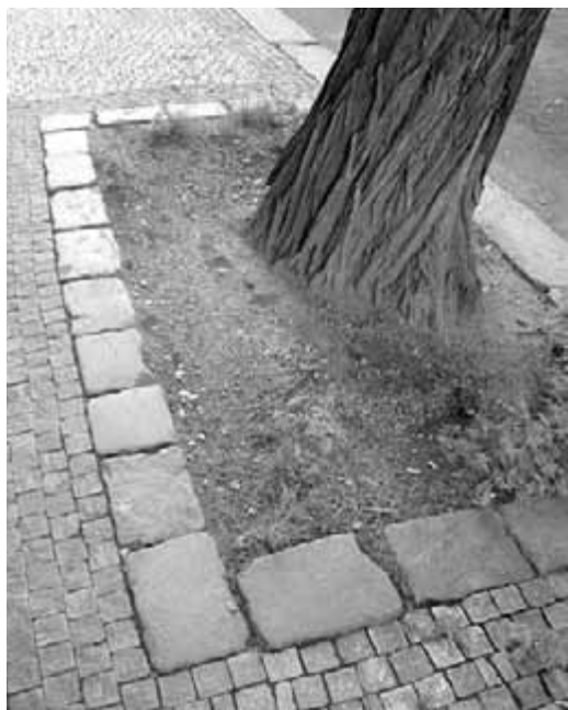
Obr. 47, 48. Zachovat je třeba i nedlážděné plochy u paty stromů a jejich původní obruby (obr. 47) stejně jako jiné, třeba jen neúplně dochované starší součásti chodníků (například takzvané anglické dvorky, obr. 48).
