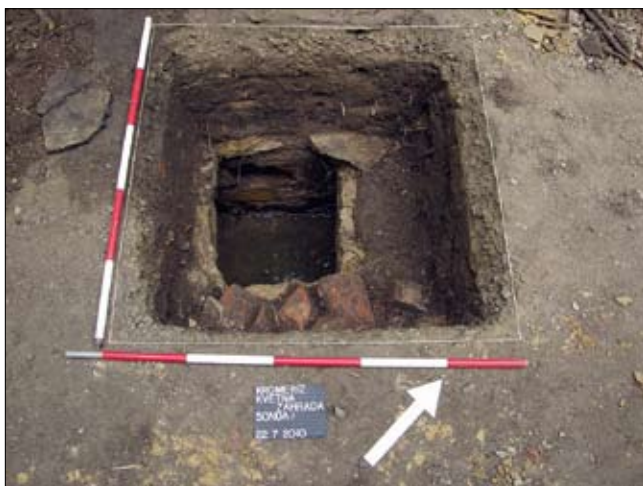
Obr. 17: Příčinou vzniku poruchy v cestě mezi Jahodovými kopečky v kroměřížské Kojetné zahradě bylo prolomení pískovcové desky překrývající revizní otvor. (Foto J. Janál)
